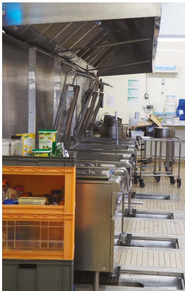
©M2 ARTESO « Cuisine centrale de Lanester en 2017 »
