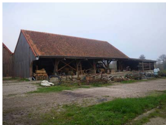
Hangar de stockage du matériel agricole au Gerموir (Ambricourt, Pas-de-Calais)
